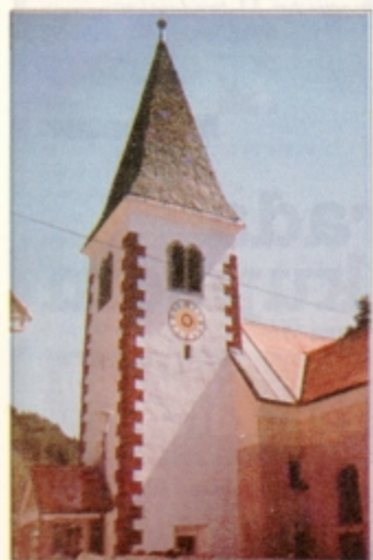
Zvonik majšperške farne cerkve je obnovljen
