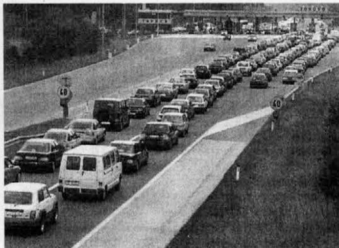
Prime code estive sull'autostrada Lubiana - Trieste e primi intasamenti sul viadotto Ravbarkomanda dove ancora per due anni saranno in corso lavori di manutenzione
