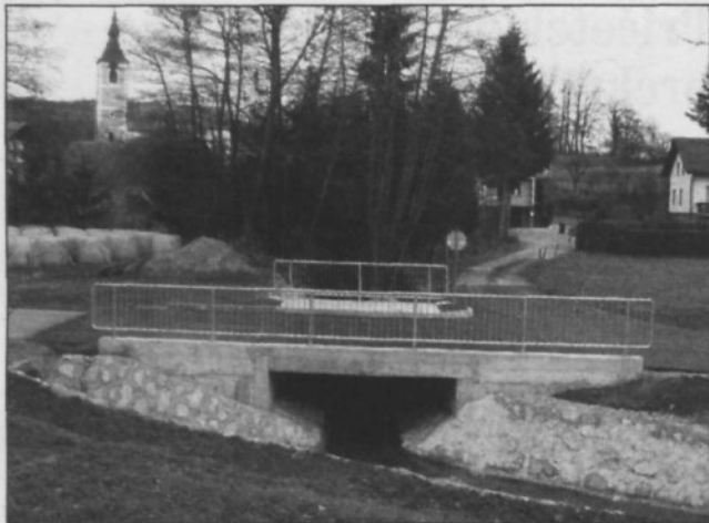
Po lanski ureditvi dveh mostov na Senušah je Občina Krško to jesen zaključila še z deli na tretjem, 5,5 metrov širokem mostu. Za izgradnjo pločnika, postavitve varnostne ograje, asfaltiranje in ureditev dela struge potoka Kaček je Občina Krško namenila 92.000 evrov in s tem izboljšala prometno in poplavno varnost.
