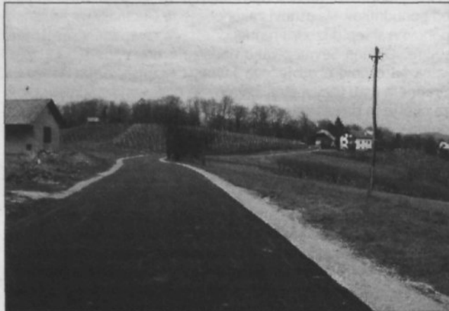
Od Kalca do odcepa za Kočno je Občina Krško na celotni dolžini 400 metrov razširila vozišče v širini enega metra. Pred odcepom za Kočno je vozišče nižano za 50 cm ter na novo asfaltirano, urejene so tudi bankine. Občina Krško je s to 47.000 evrov vredno investicijo tako tudi na tem območju izboljšala vozne pogoje in preglednost.
