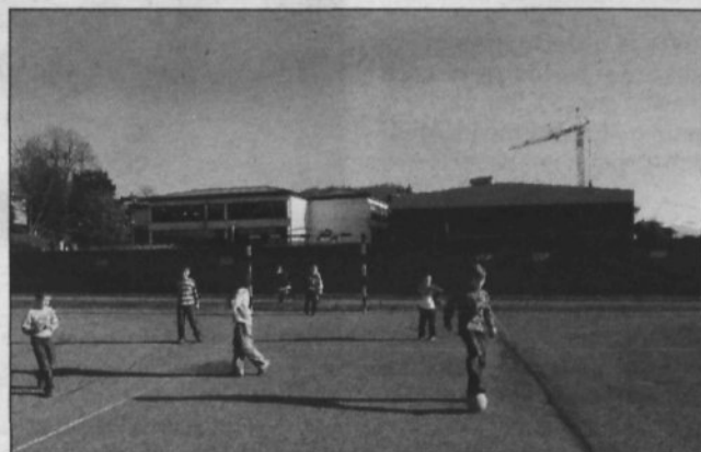
Gradbišče telovadnice pri OŠ Jurija Dalmatina
