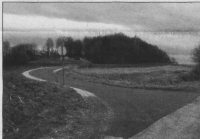
Vozišče je sanirano tudi na relaciji Krško - Gora. 700 metrov dolg odsek je v celoti tudi na novo preplasten. Investicija je vredna 30.000 evrov, sanirani pa so tudi posedki, ki so bili posledica prekomernih obremenitev.
