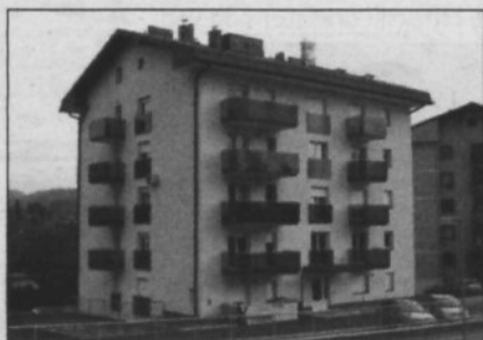
Večstanovanjski objekt, v katerem je 24 stanovanj.
