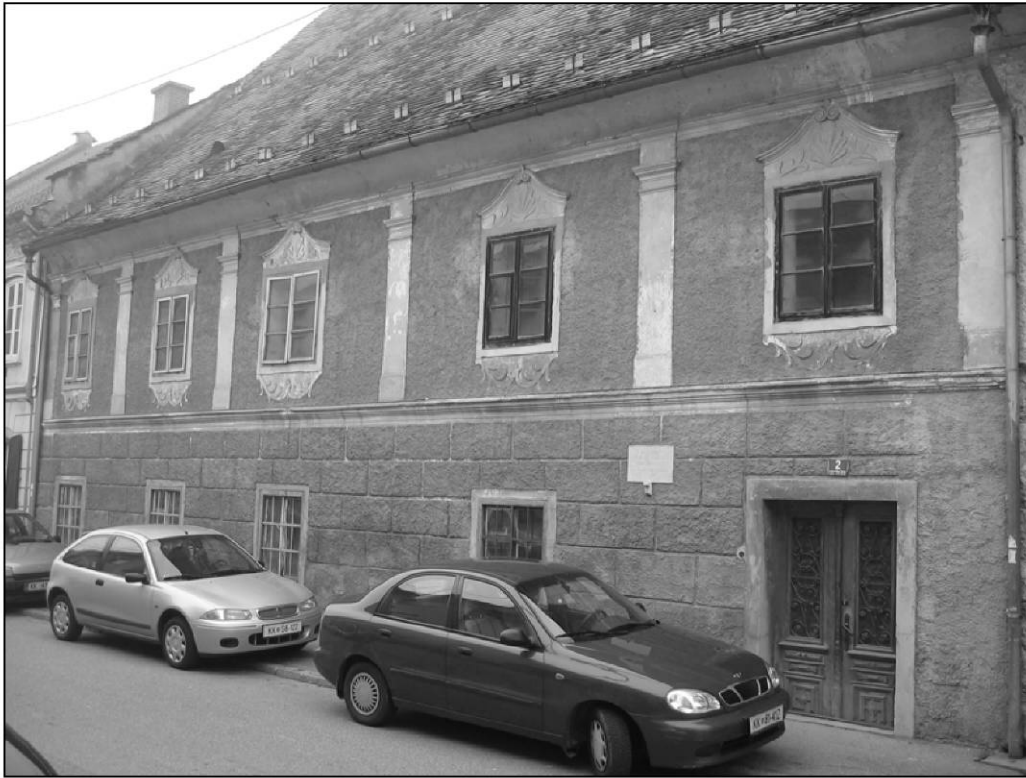
Prava Valvasorjeva hiša, poznejša Zetschkerjeva, je današnji južni del Mencingerjeve hiše, združene iz dveh stavb. Pred prenovo (foto: Boris Golec, december 2006).
