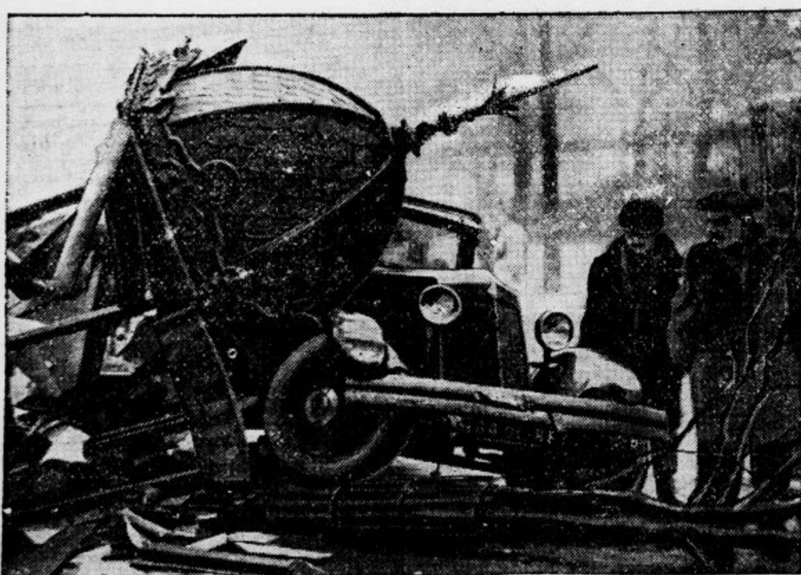
V Parizu so imeli pred dnevi tako gosto megle, da se je primerilo mnogo nesreč. Med drugimi je posebno značilna ta, ki jo prikazuje naša slika. Avto se je zaletel s takšno silo v kloak za časopise, da ga je podrl na ulico.
