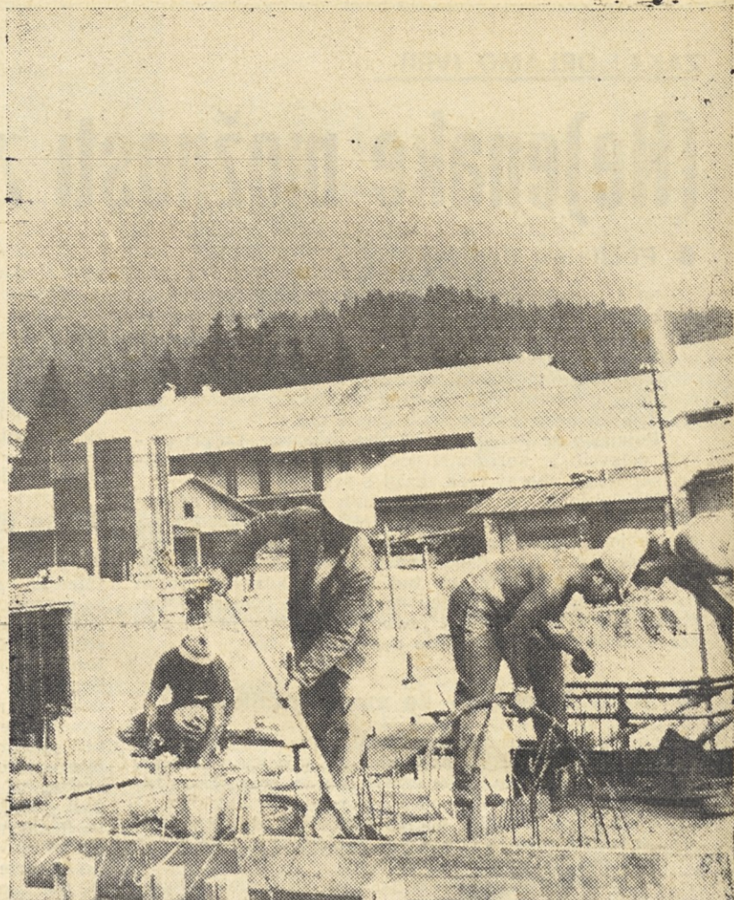
Betoniranje stebrov v Kranjski gori
