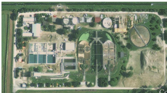
Slika 15 • Začetek gradnje nove, tretje čistilne naprave SBR
