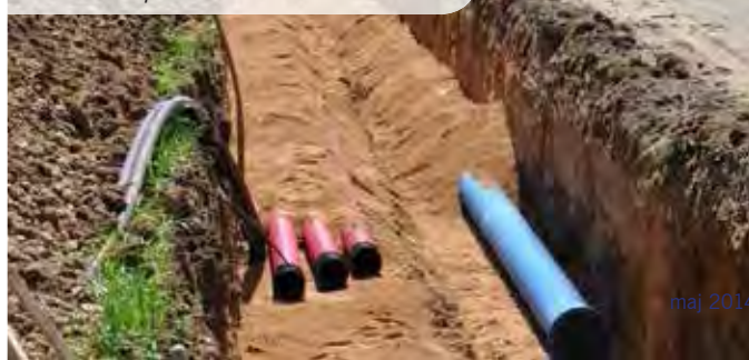
Prvi metri položenih vodovodnih cevi
