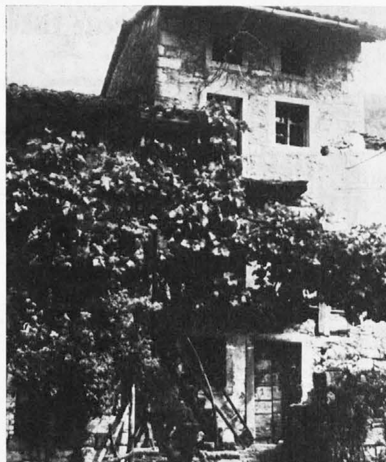
V tej hiši, ki danes razpada, je bil med to zadnjo vojno glavni štab partizanskih enot in angleška vojaška misija «Divizije Garibaldi del Friuli»
