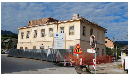
Stavba stare šole bo po delni rušitvi in dograditvi postala Hiša generacij. (hrani: arhiv Občine Gorenja vas - Poljane)
