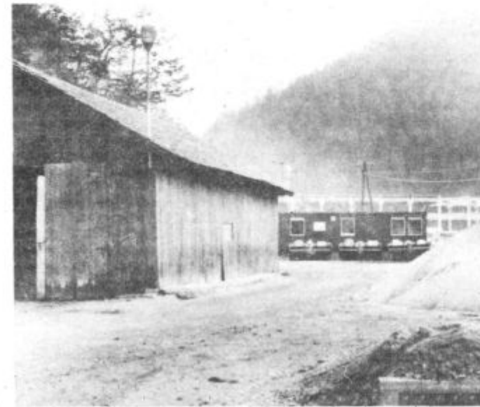
Že zunanost cestno-vzdrževalne enote v Selu kaže v kakšnem stanju je.
