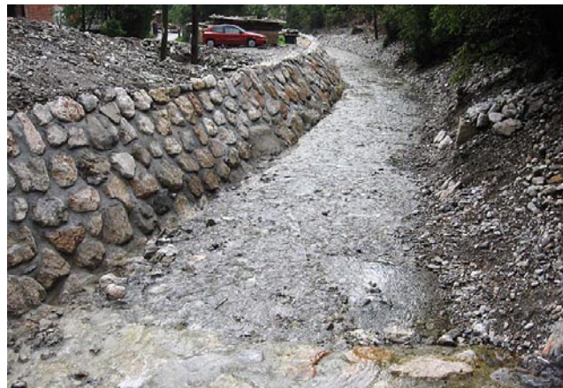
Slika 8 • Struga hudournika Nidrarska grapa v Podroštu po dokončanju sanacijskih del (Vir: arhiv VGP, d. d., Kranj)
