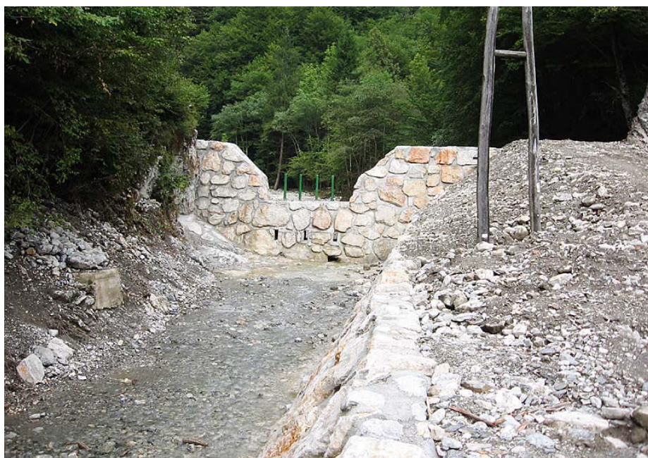
Slika 9 • Nova pregrada za zaustavljanje plavin na hudourniku Nidrarska grapa nad naseljem Podroš (Vir: arhiv VGP, d.d., Kranj)
