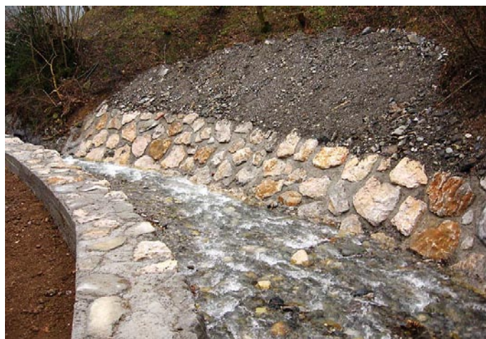
Slika 4 • Struga hudournika Češnjica skozi naselje Rudno po dokončanju sanacijskih del (Vir: Arhiv VGP, d. d., Kranj)
