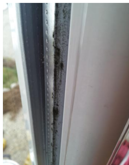
Slika 1 • Rast plesni na okenskem okvirju (Pajek, 2013)
