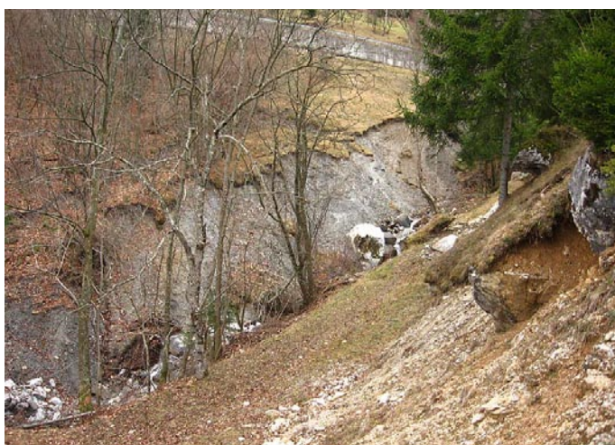
Slika 5 • Poškodovana struga hudournika Dašnjica v Podlonku pred sanacijo (Vir: arhiv VGP, d. d., Kranj)
