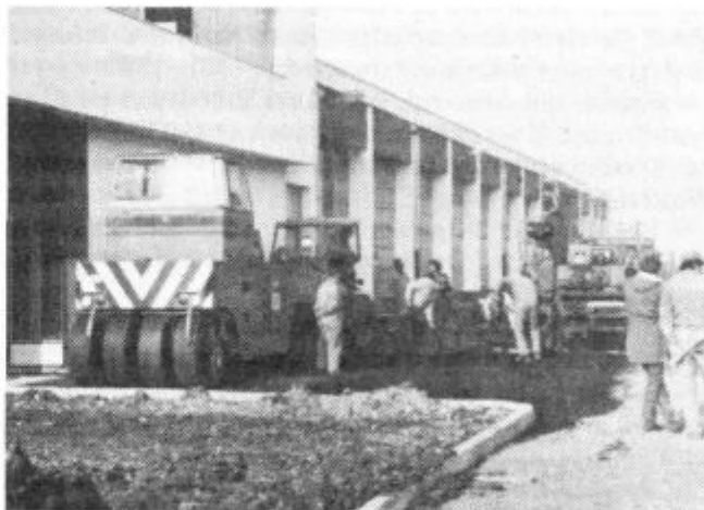
Zaključna dela pri izgradnji servisa
