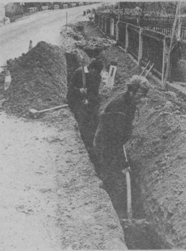
ŠMARJE-SAP — Šmarčani dobivajo nove telefonske priključke. Pri tem so si pomagali sami, na pomoč pa so jim s prostovoljnimi delom pred časom priskočili tudi delavci PTT Ljubljana. Seveda pa vsega niso zmogli, zato te dni polagajo cevi za PTT vode. Delavci, ki so zaposleni v PAP Ljubljana, kopljejo za poštarje jarke in polagajo cevi na kilometer dolgi trasi v Šmarje Sapu. — Foto: Marjan Ciglič
