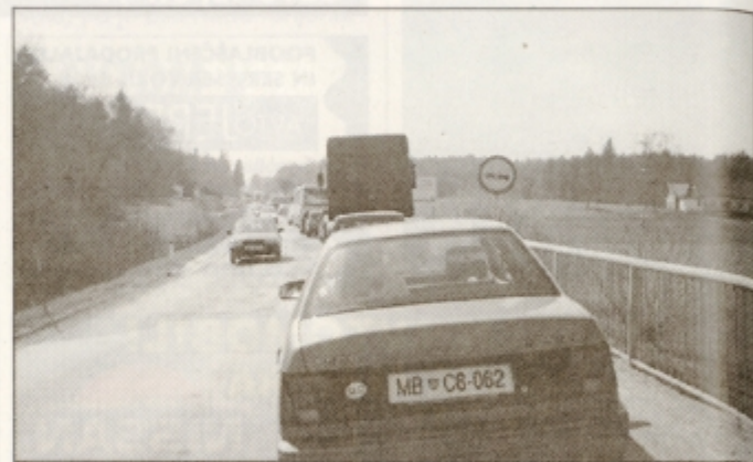
Gradnja odseka magistralne ceste med Črnim Lesom in mostom na Globovnici povzroča občasne kolone
