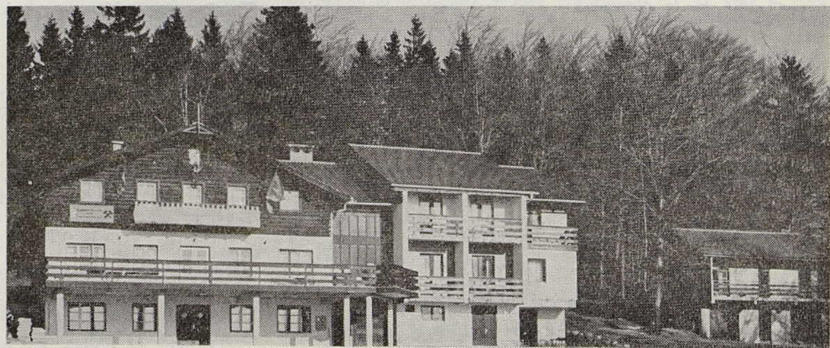
29. novembra je bila otvoritev obnovljenega Planinskega doma na Kalu. V neposredni bližini doma je že od lani urejeno tudi smučišče, vanj pa je vgrajenih precej prostovoljnih delovnih ur delavcev nekaterih hrastniških kolektivov.
