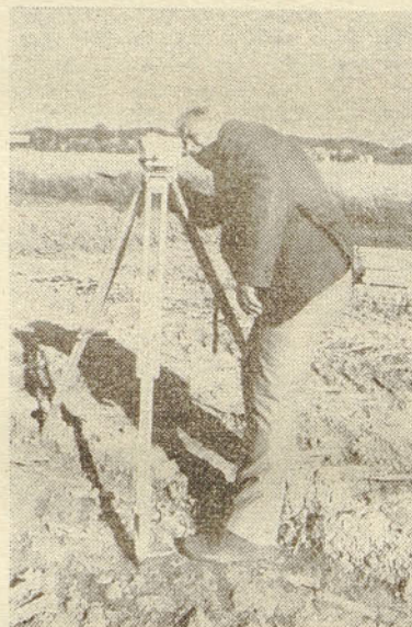
Geometer Janez Sajevec kontrolira višine pri melioracijah
