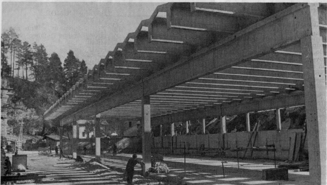
Priprave za pokrivanje in druga zaključna dela na sortirno skladiščni lopi (foto Ažman)
