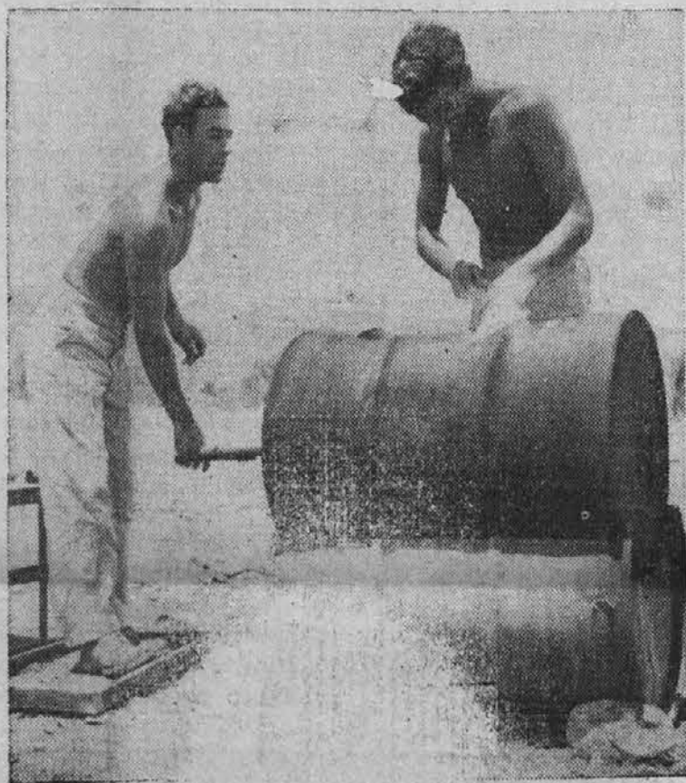
Kaj bi rekle naše perice, če bi imele take vrste pralni stroj? — Dva soda od olja služita našim vojakom za pralni stroj. V spodnjem sodu je kurivo, v zgornjem pa je perilo v vroči vodi. Slika je bila posneta na Guadalcanalu.
