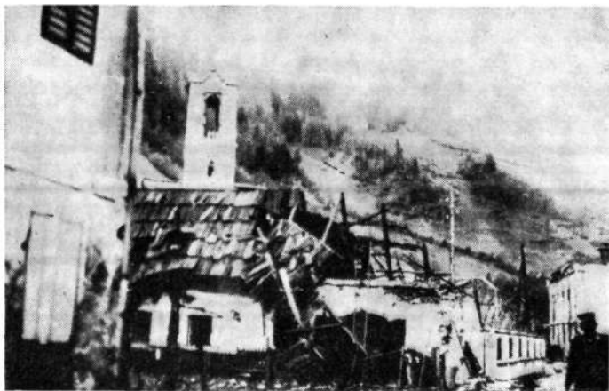
Del porušenih in požganih Železnikov
