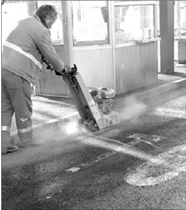
Delavec z rezkalnikom odstranjuje talni »stop«
