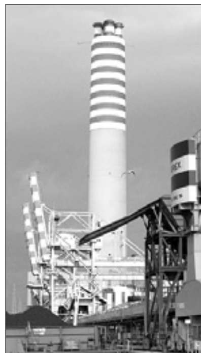
Dimnik tržiške termoelektrarne
