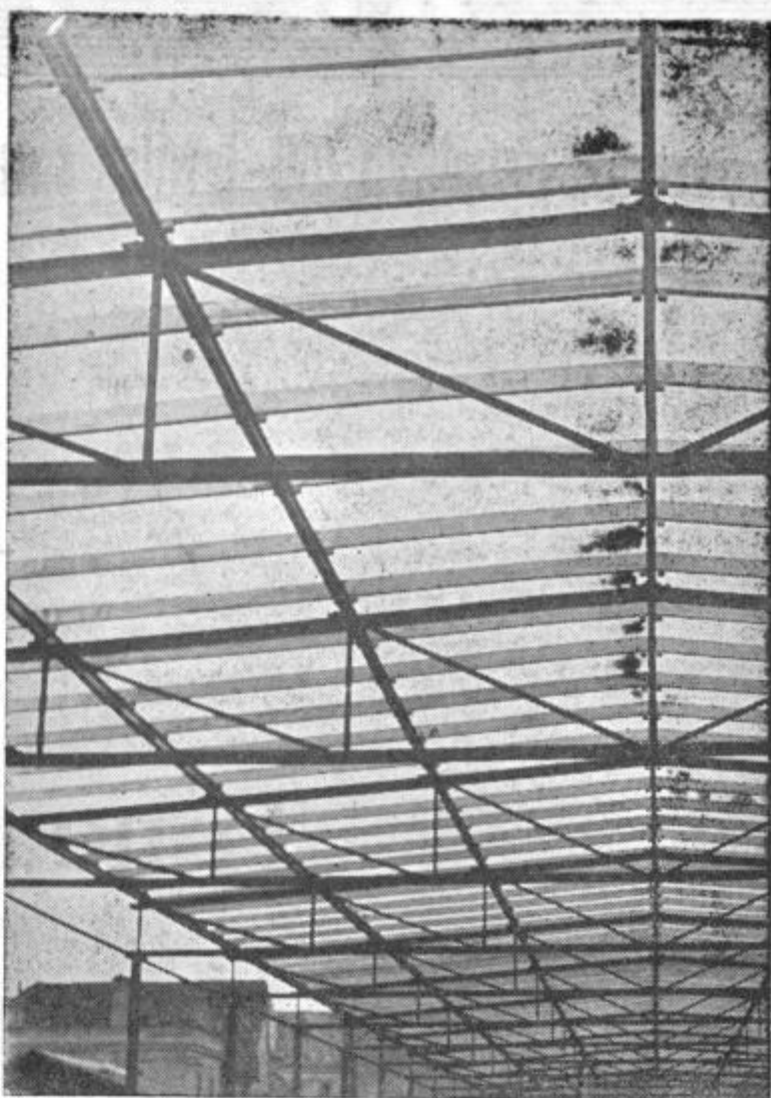
Nosilna konstrukcija nove tržnice v Celju.
