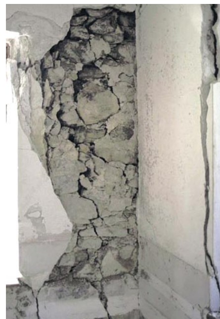
Slika 6 • Posočje, 1998: razslojevanje kamnitega zidovja
