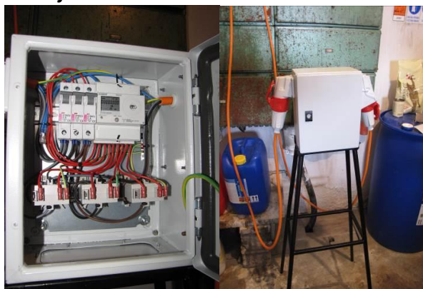
Slika 4: Elektronski merilnik porabe električne energije z možnostjo enostavne in varne priključitve na električne stroje
