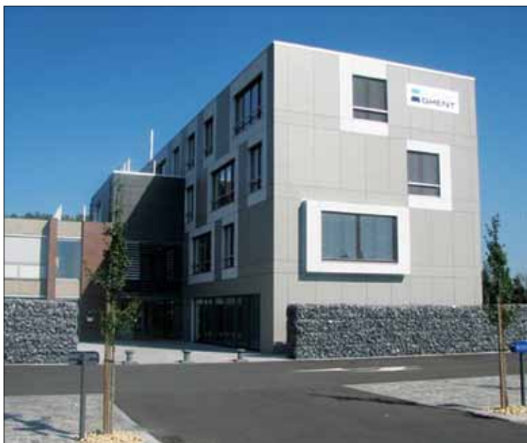
Pisarniška stavba Port of Ghent, Belgija
