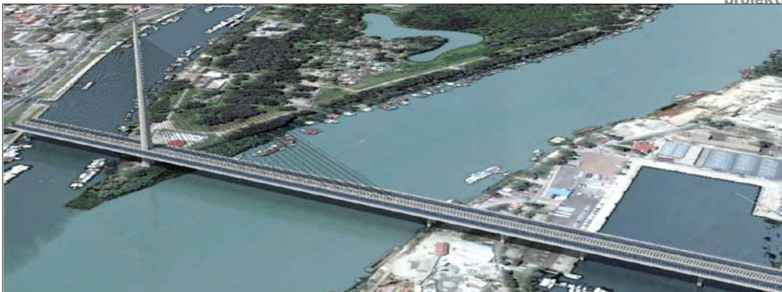
Končni izgled mosta
