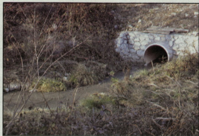
Kanalizacijska cev, ki je ne bi smelo biti
