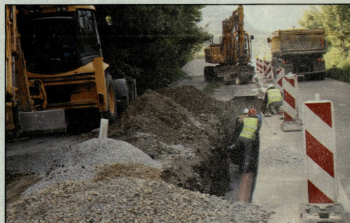
Pri gradnji kolektorja na cesti Žalec-Griže
