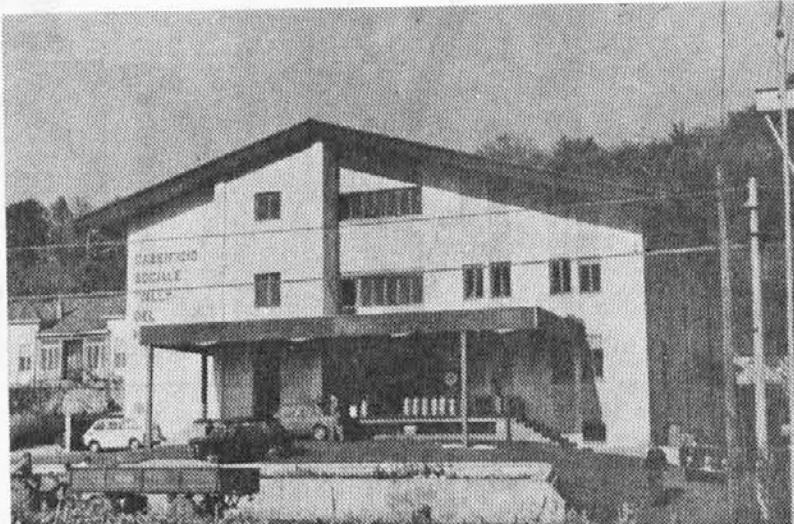
Latteria di Azzida
