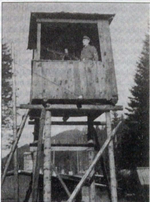
Stražni stolp na severni strani s pritrjeno pomično strojnico.
