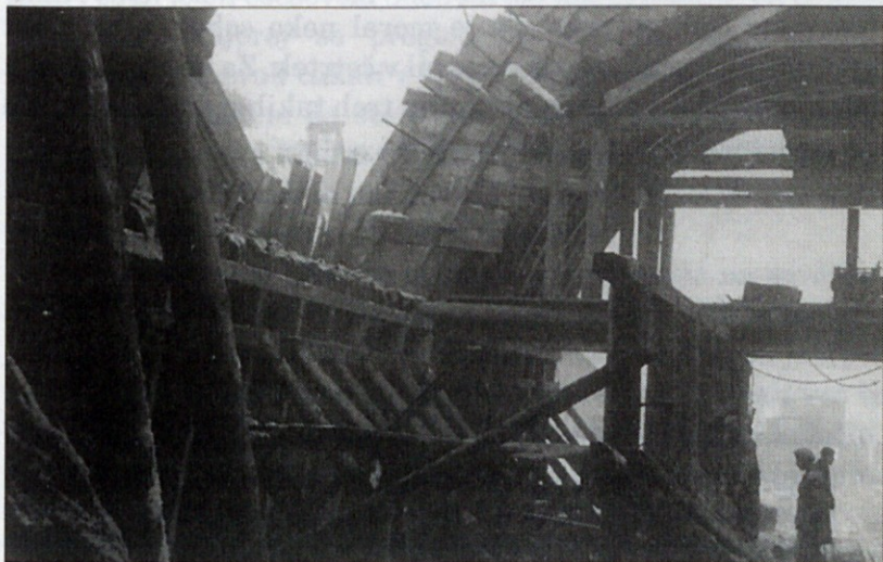
Gradnja in betoniranje obokov.
