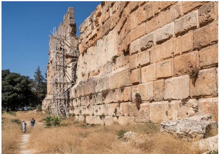
Slika 71: Starodavni temelj stavbe v Baalbeku.
