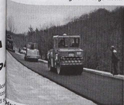
odsek ceste pri Zalčju dobiva novo asfaltno prevleko
