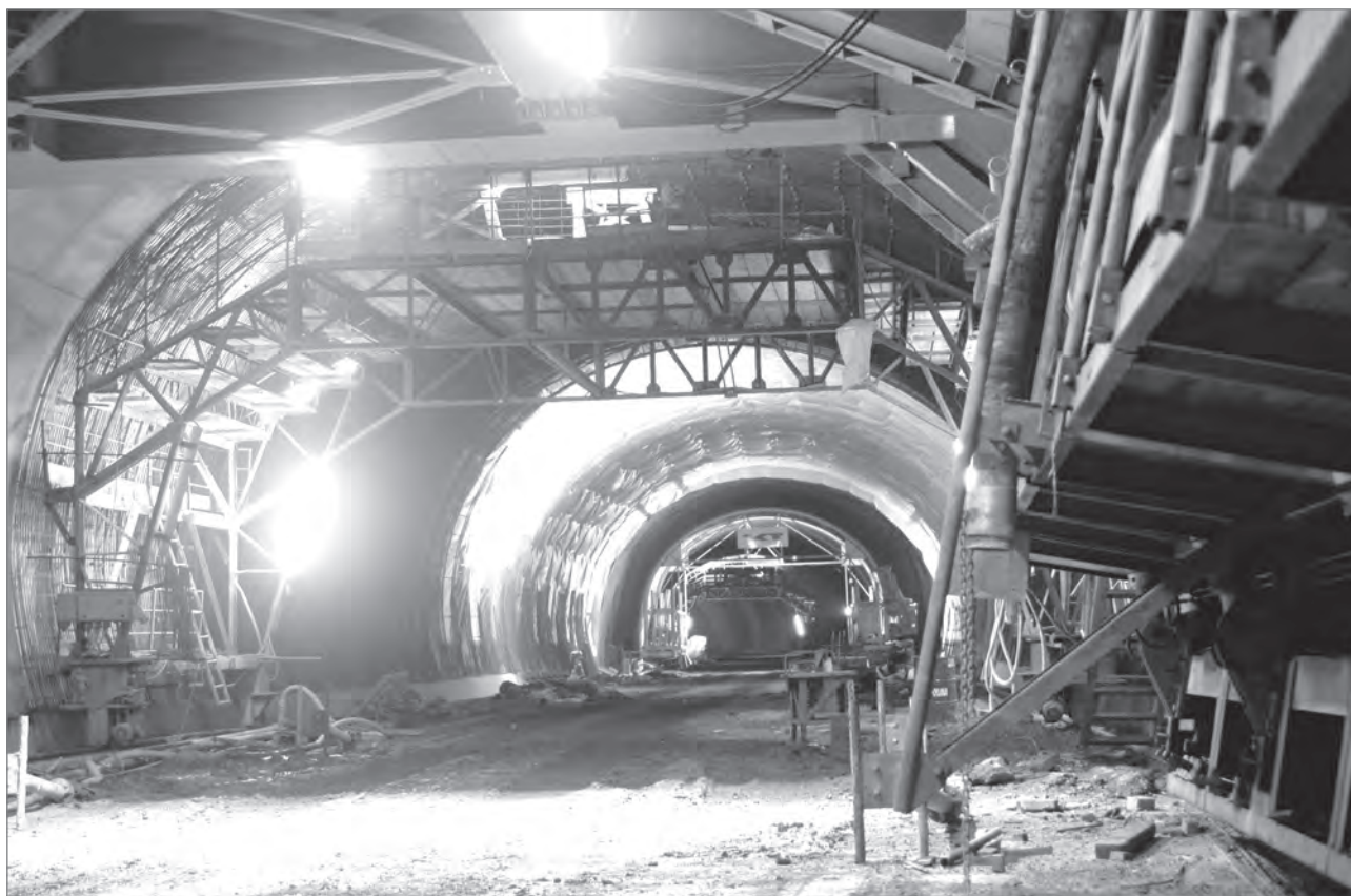
Slika 11: Gradnja predora Trojane (foto: arhiv Projekta Trojane, 2002)
