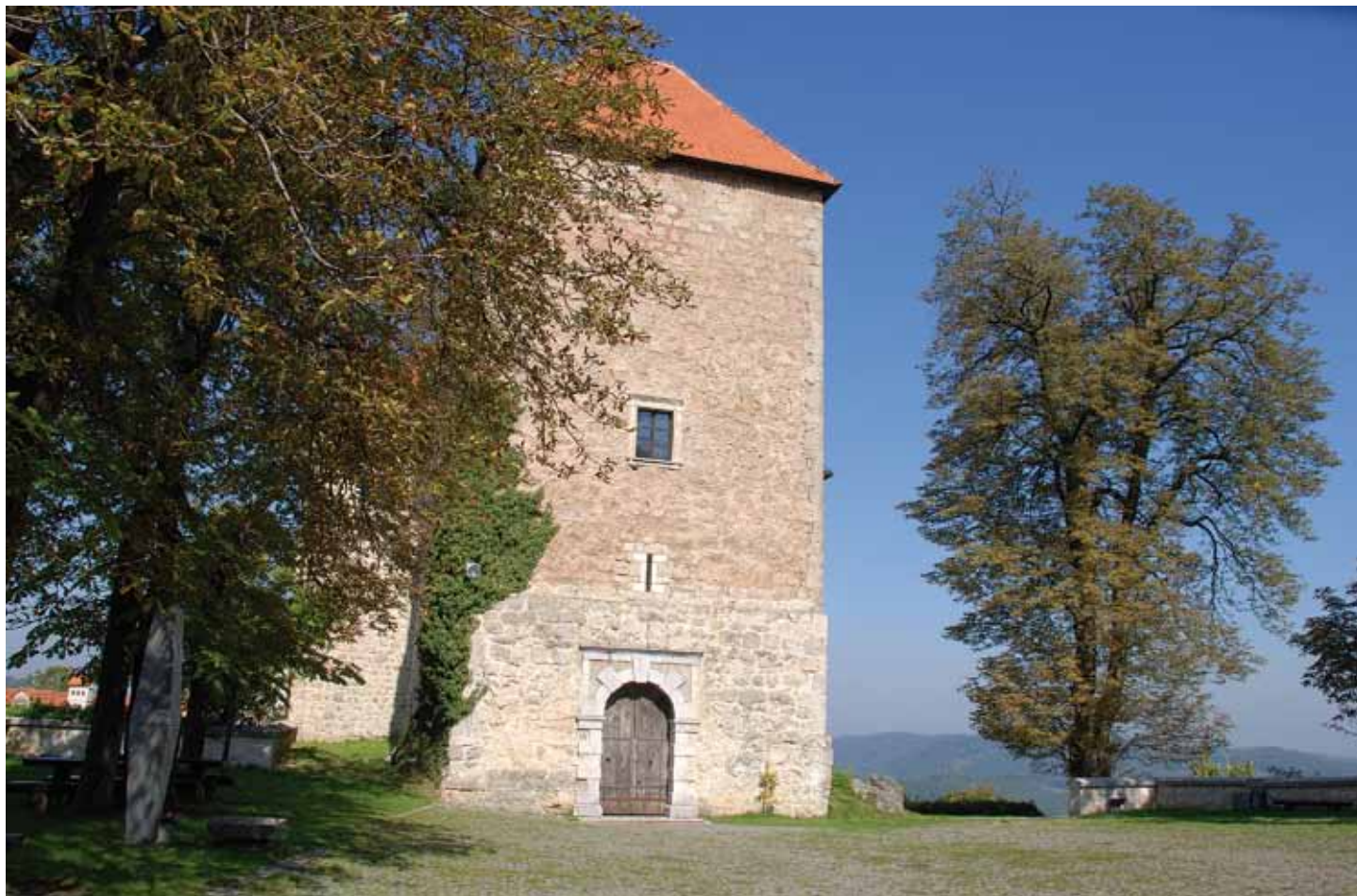
Slika 15: Pogled na mogočno grajsko dvorišče z divjimi kostanji. Foto: Tonka Šoba, 2015.
