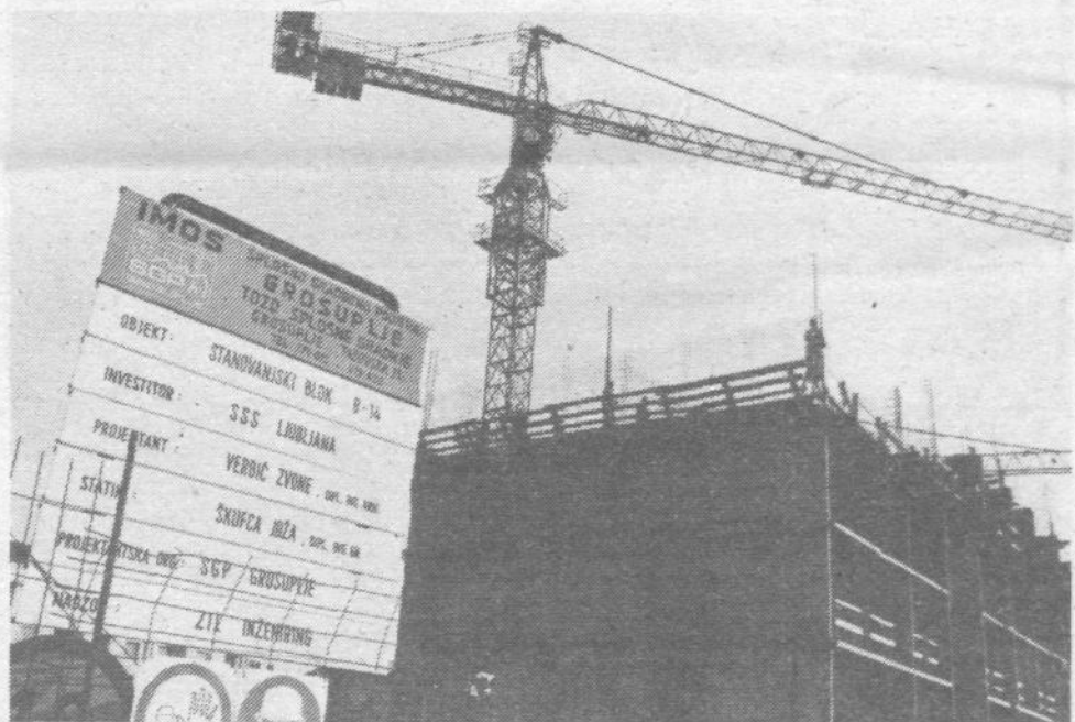
Na mestu, kjer je nekoč stala poklicna kovinarska šola, delavci SGP Grosuplje gradijo nov stanovanjski blok, sto metrov stran ob avtobusnem postajališču pa kopljejo kanal za povezavo bloka s plinskim omrežjem.
