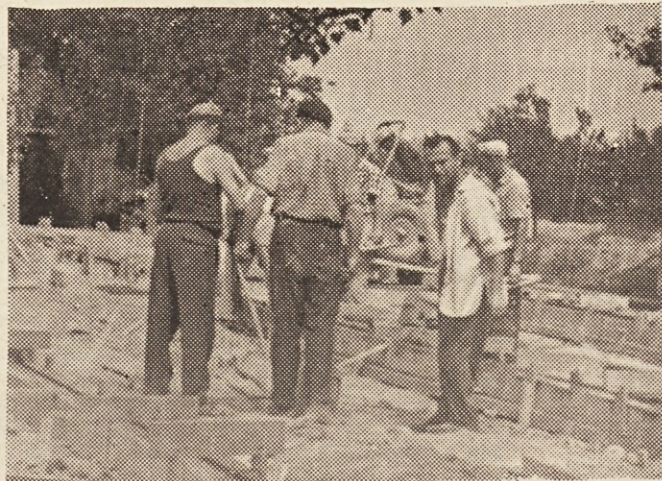
Skupina delovodje Pavliča pri pripravljalnih delih za betoniranje temeljev
