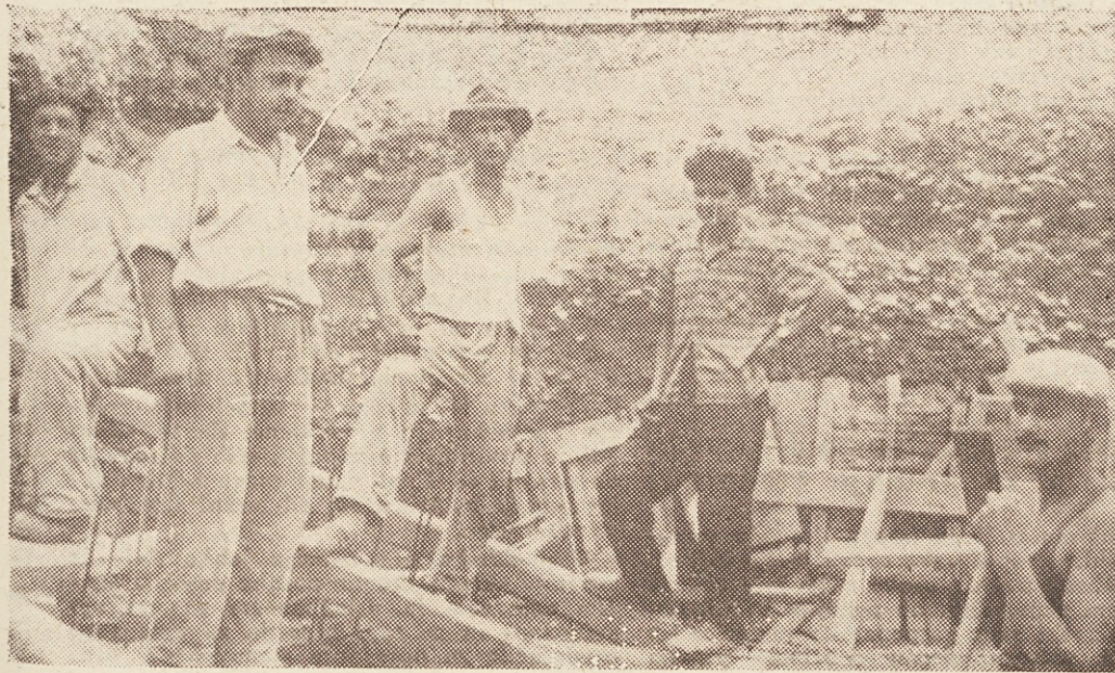
Trenutek odmora v gradbeni jami. Izkopati so morali preko 5000 m 3 materiala. Stavba je tik ob Titovi cesti v Ljubljani
