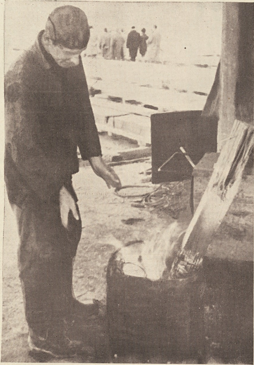
Približala se je zima z vsemi neprijetnostmi za gradbene delavce. V hudem mrazu primitivno postavljena peč zaleže le malo
