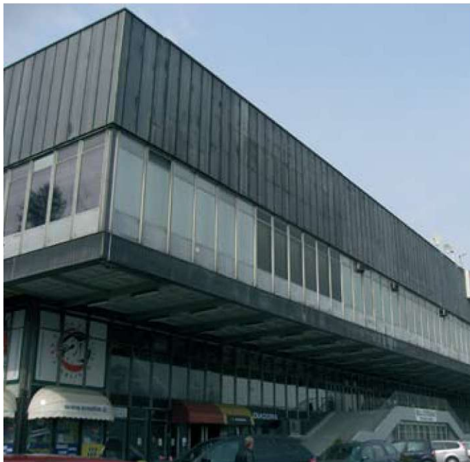
Slika 5: Marjan Božič: previsna jeklena konstrukcija Hale Tivoli v Ljubljani. Figure 5: Marjan Božič: Overhanging steel structure of Tivoli Hall in Ljubljana.
