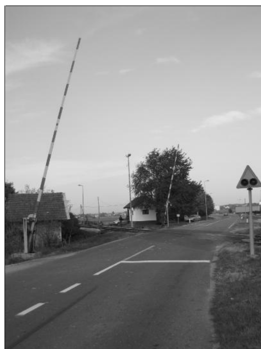
Slika 8: Zapornice na postaji Središče, zapira jih zaporna arka.
