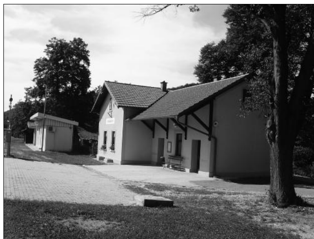
Slika 16: Signalno–varnostne naprave se ve inoma vgrajujejo v zabojnike ob obstoje e zgradbe, ki s asoma zgublajo pomen, eprav lahko služijo za akalnico. Na ve ini postaj stanujejo v njih tudi zaposleni ali upokojeni železni arji. Obnova postajne zgradbe na postaji Ivanjkovci sprva ni bila predvidena, nato pa se je leta 2007 z velikim angažiranjem vplivnih ljudi le zgledno uredila. Foto: Franc Zemlji , Ivanjkovci, 12. 8. 2008.
