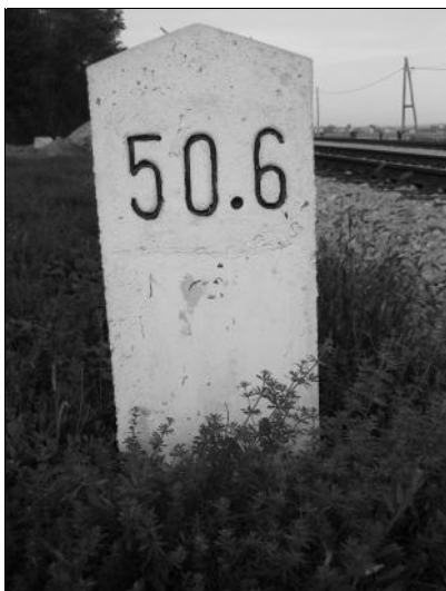
Slika 14: Ozna ba km lege. Ob progi je na vsakih 100 m en kamen. Kamen na sliki ozna uje km lego 50,6 km od za etka proge, tj. od Pragerskega. Foto: Franc Krnjak, Središ e, 2. 10. 2008.
