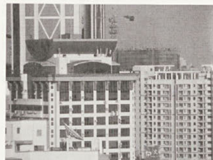
Pogled na stavbo, v kateri je pisarna
