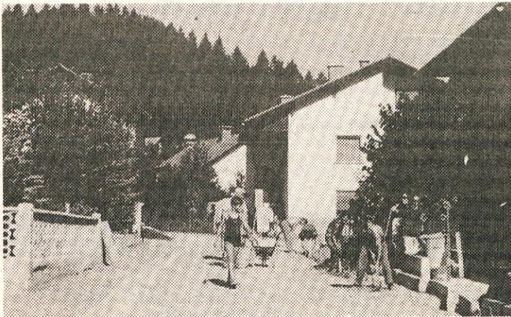
Gradnja ulice na Lazah.
