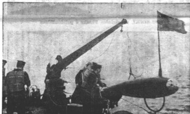
ČIŠČENJE SEVERNEGA MORJA. Angleška mornarica lovi mine v Severnem morju s posebnimi pripravami, ki so med seboj povezane s kablji
