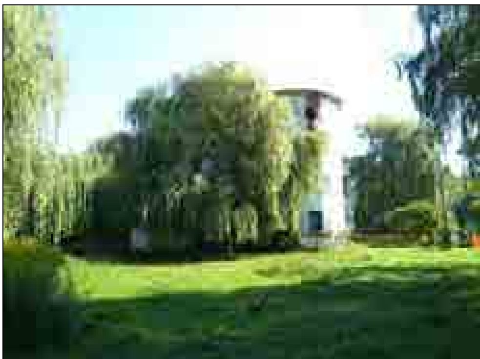
Dobrnež 3. Dediščinsko in gradbeno razvrednoteno zunanjščino dvorca Golič zakrivajo neavtohtone vrbe, ki so jih pred leti zasadili stanovalci, da lahko poleti uživajo v prijetnem hladu (foto: V. Hazler, 17. 7. 2009).
