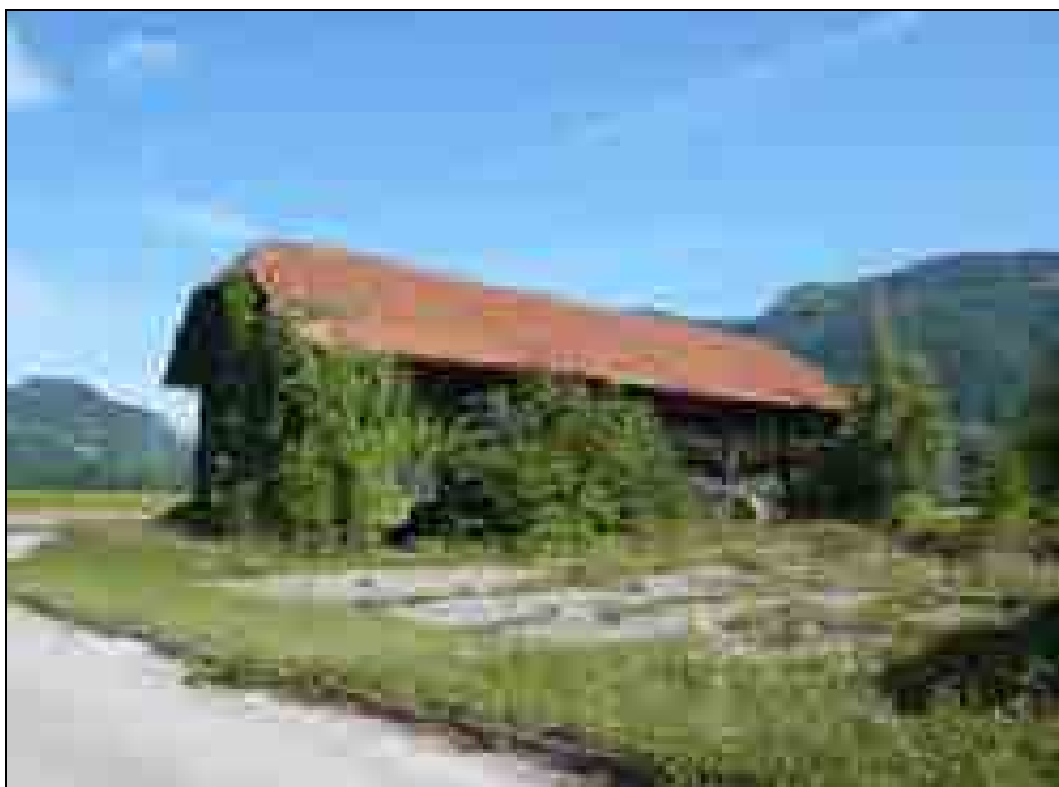
Kozolec pri dvorcu v Hotemežu z jugovzhodne strani, kjer ga že zarašča grmičevje in obrašča srobot (foto: V. Hazler, 14. 8. 2011).
