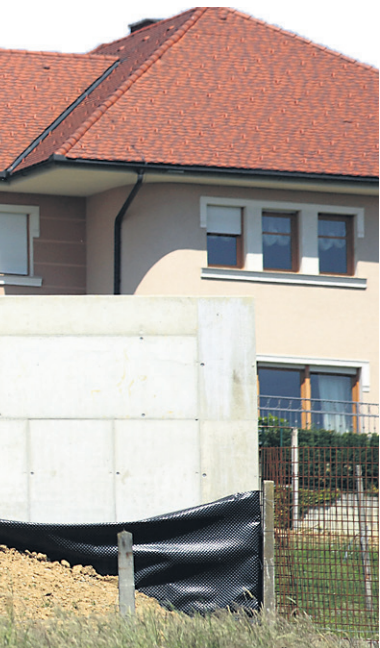
Foto: Črtomir Goznik velikokrat zgraditi podporni zid, da se
