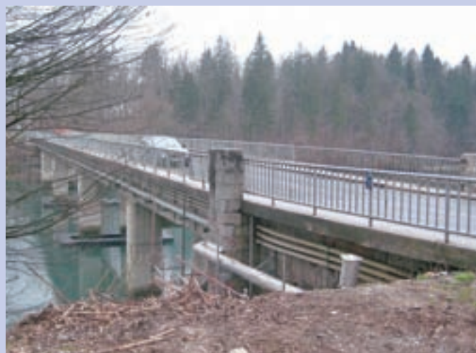
Obnova mostu čez Savo pri Smledniku naj bi bila končana do konca oktobra.
