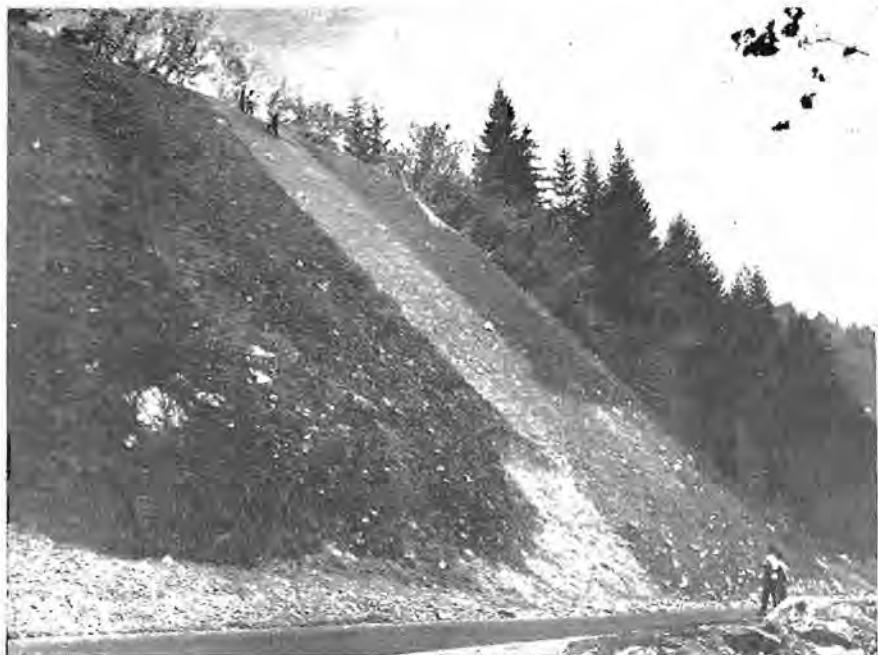
Slika 11. Pokrivanje s slamnim nastilom, setev in brizganje emulzije po pobočju globokega odkopa na novi avtomobilski cesti na Ljubelju (orig.)
