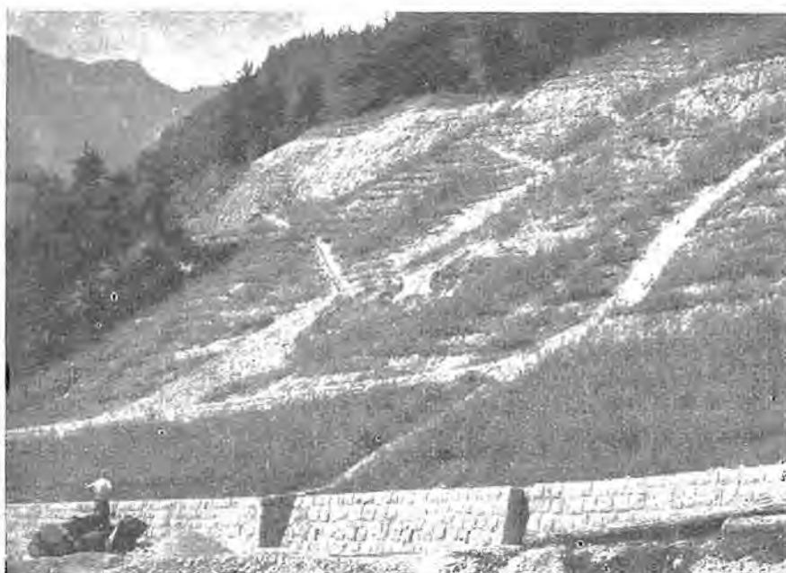
Slika 6. Zavarovanje udara nad cesto Trenta—Zadnjica z odvodnimi jarki in živimi ščetkami (orig.)
