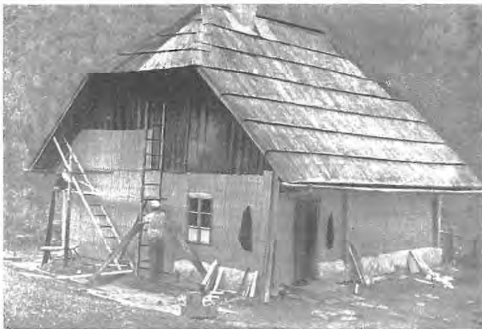
Slika 10. Gozdarska delavska koča na Komisiji nad Mislinjami je značilna zaradi svojevrstne gradnje in stenske oplate iz skodel (orig.)
