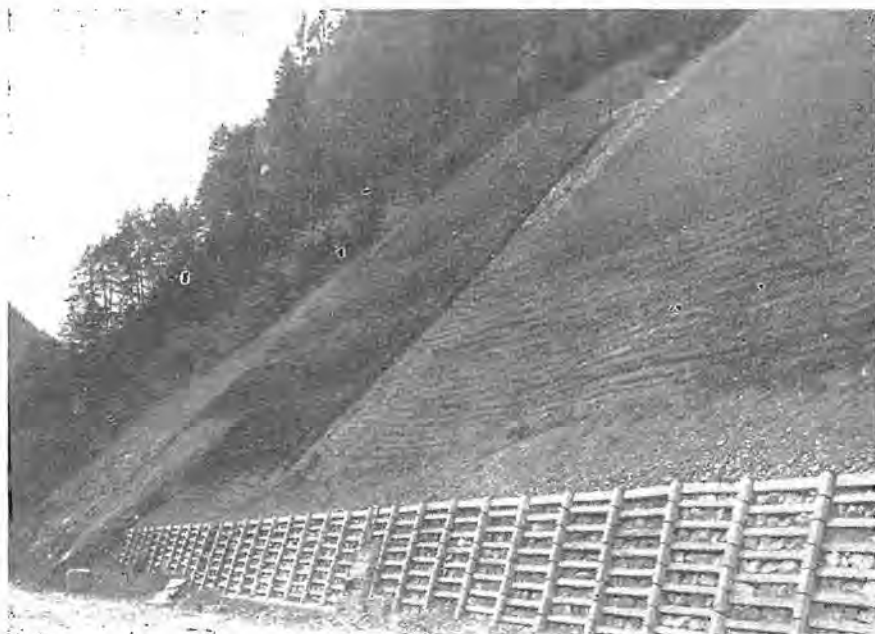
Slika 12. Pozelenitev visokega pobočja v odkopu na novi avtomobilski cesti na Ljubelju v več fazah (orig.)
