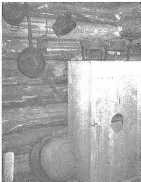
Slika 7. Levo: Notranjost drvarske bajte s klopjo, omaro za hrano, posodo za kuhanje in lempjo za vodo. Desno: Ognjišče, zgrajeno iz tanjših brun, pravokotnega tlorisa. Notranjost je nabita z ilovico, pograd je zaščiten pred iskrami s pločevino na koncu ognjišča; v pokončne letve ob straneh zatikajo ponve in druge posode z ročaji (orig.)
