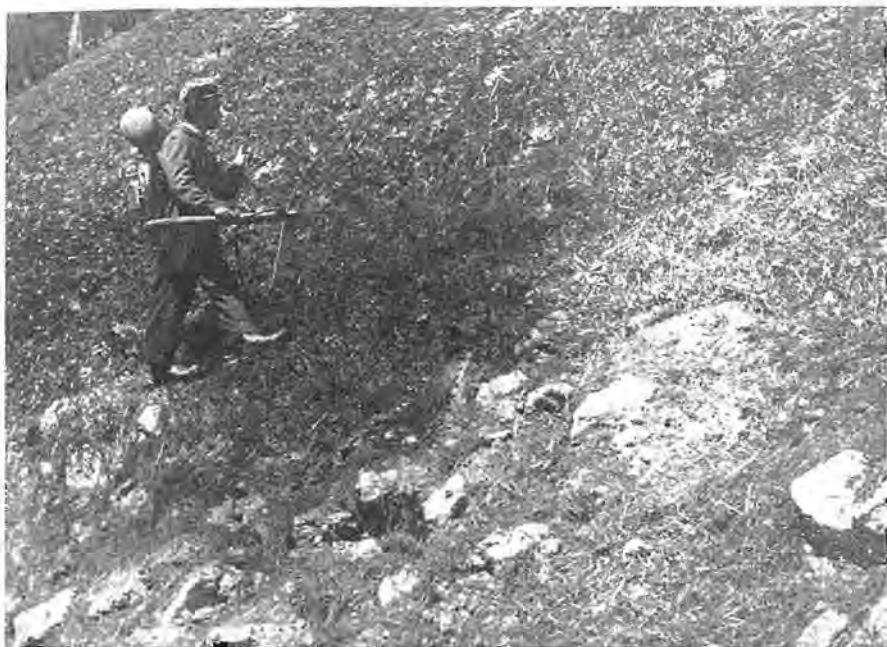
Slika 10. Brizganje bitumenske emulzije na opravljeni posevek po nastilu na pobočju odkopa nove avtomobilske ceste na Ljubelju (orig.)
