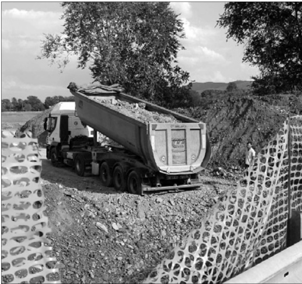
Gradbišče avtoceste v Sovodnjah
