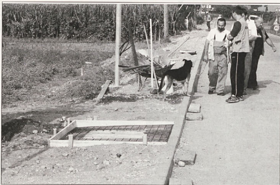
Izgradnja pločnika in razsvetljave v centru Lancove vasi.
