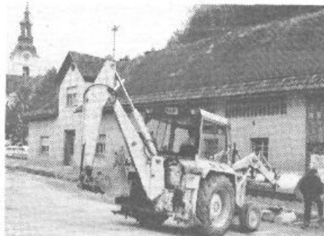
Nadaljevanje gradnje kanalizacije
