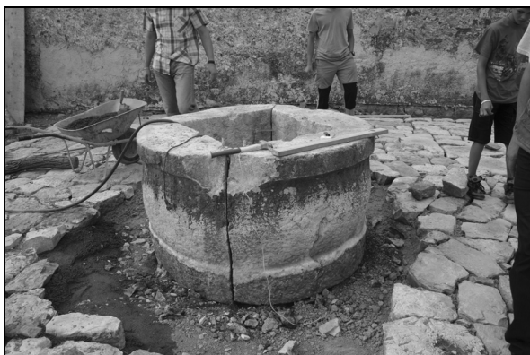
Avгust 2006. Kamniti oklep čaka, da ga dvignejo na izravnavano površino tlaka, očistijo in pokrpajo. Na zgornjem robu je lepo viden odškrnjen del, kjer je bila nameščena ročna črpalka (foto: E. Belingar, 2006).
